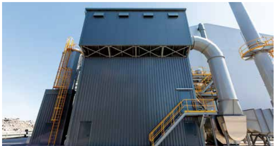
De filterinstallatie vangt het stof af dat tijdens het kiepen vrijkomt.
